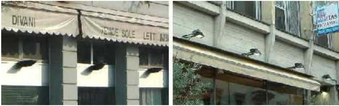
Fig.20 - (a sinistra) Una vetrina illuminata in modo non conforme alla normativa, dal basso verso l'alto. (a destra) Illuminazione conforme alla L.R. 19/2003. [Immagine fornita da CieloBuio]
