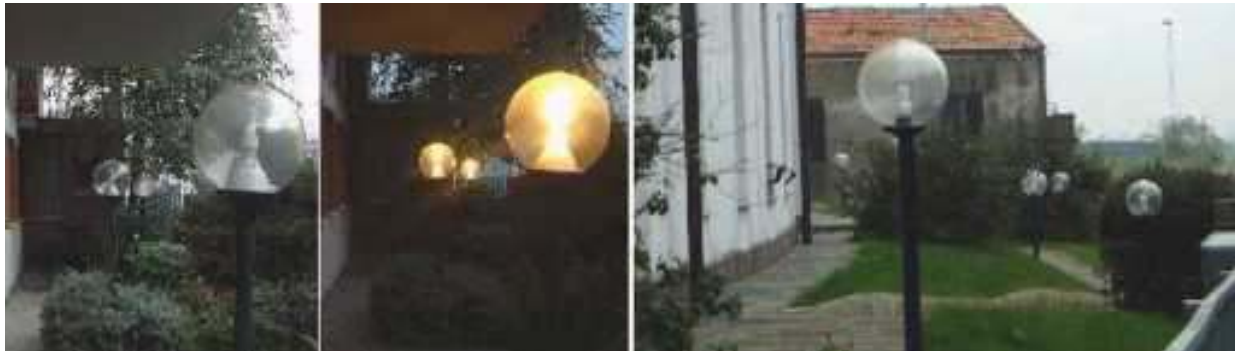
Fig.24 - Nelle 2 foto di sinistra l'illuminazione è conforme alla deroga con 3 punti luce non schermati di max 23W a fluorescenza compatte. Nella foto di destra però la deroga non è applicabile a meno che il flusso emesso verso l'alto sia inferiore a quello emesso da 3 punti luce da 23W (utilizzando ad esempio potenze inferiori o schermature) equivalenti a 2250 lumen. [Immagine fornita da CieloBuio]
