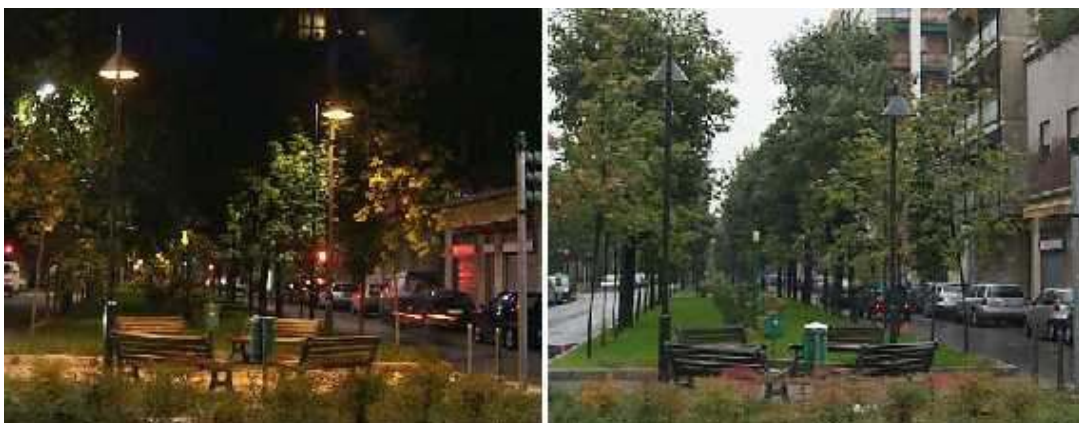
Fig.9 - Illuminazione (notturna e diurna) di aiuole e di giardini con impianto conforme alla L.R..19/2003 e della relativa direttiva applicativa [Immagine fornita da CieloBuio]
